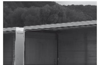
Keine über das Dach hinausstehenden Seitenwände
